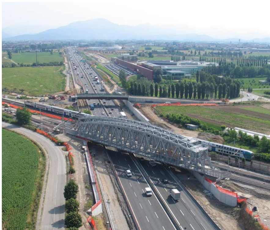
Figura 4.11.1 – Veduta dei due ponti ferroviari.
